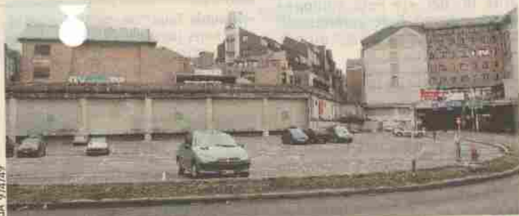
La dalle est toujours inachevée du côté du théâtre Jean Vilar. Un gros chantier s'y ouvrira dans les cinq ans.
